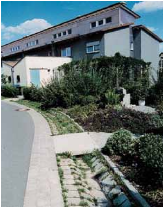
G17 | Links: Beispielhafte Regenwasserversickerung in einem Neubaugebiet. Rechts oben: Regenrückhalteteich in Neubausiedlung. Rechts unten: Versiegelungsarme Zufahrt durch Verwendung von Rasengittersteinen.
