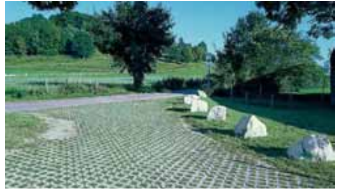
G17 | Links: Beispielhafte Regenwasserversickerung in einem Neubaugebiet. Rechts oben: Regenrückhalteteich in Neubausiedlung. Rechts unten: Versiegelungsarme Zufahrt durch Verwendung von Rasengittersteinen.
