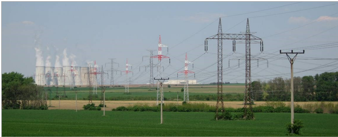
Abb. III.17: Technische Elemente als Bestandteil des Landschaftsbildes
