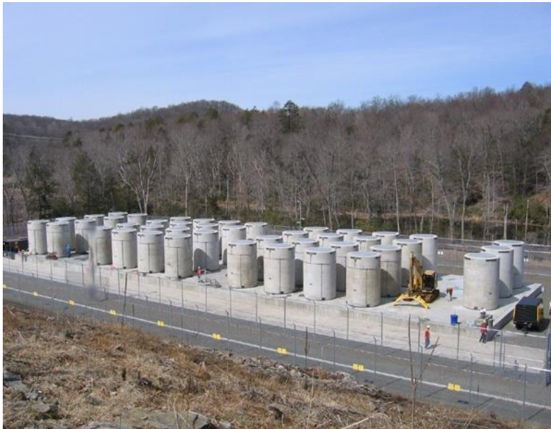
Abbildung 98: Charakteristische Anordnung im Fall von trockener Containerlagerung [44]
