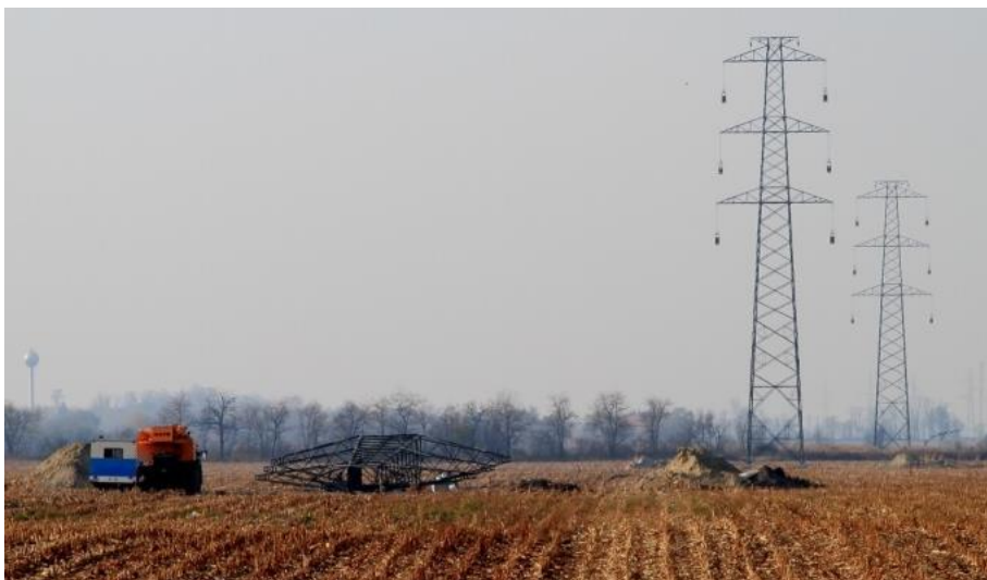
Abbildung 45: Martonvásár-Győr 400 kV Freileitung, Mastaufbau
