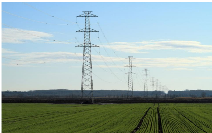
Abbildung 43: Martonvásár-Győr 400 kV Freileitung mit FENYŐ (Tanne) Typ Mäβten
